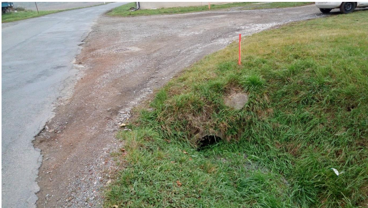
Obr. 27: Vyústění propustku
