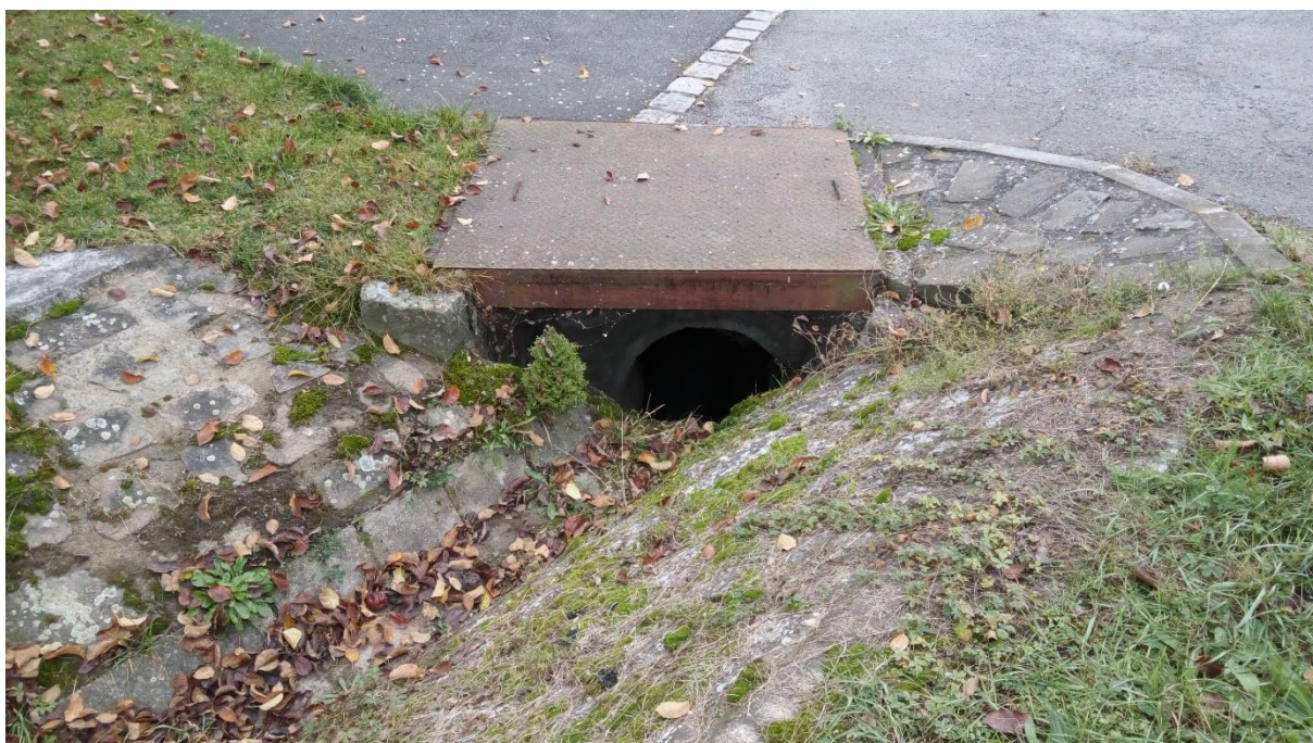
Obr. 30: Propustek v trase cestního příkopu
