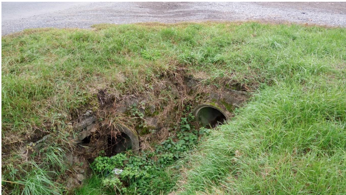
Obr. 26: Propustek pod komunikace
